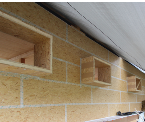
(IX.16) Vzduchotěsná vrstva je připravena pro kladení slaměných balíků, které se odehrálo během workshopu sdružení Ekodům.
