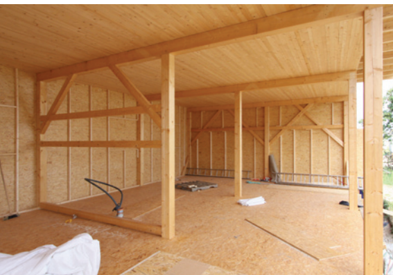
(IX.15) Opláštění stavby vzduchotěsnou vrstvou OSB desek proběhlo na relativně subtilní výplň konstrukčních polí z latí 40 x 60 mm.
