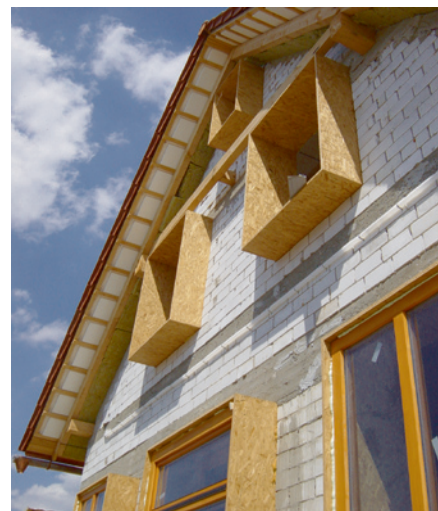
(VII.73) Zděná stavba z vápenopískových cihel, která bude zaizolována minerální vatou.
